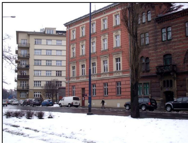
Budynek przy ul. Lenartowicza 14 – od roku 1997 siedziba Zarządu Wojewódzkiego, a od roku 1999 Małopolskiego TKKF.
